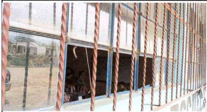
FOTO 1: SUSTITUCION DE VENTANAS A PCV
