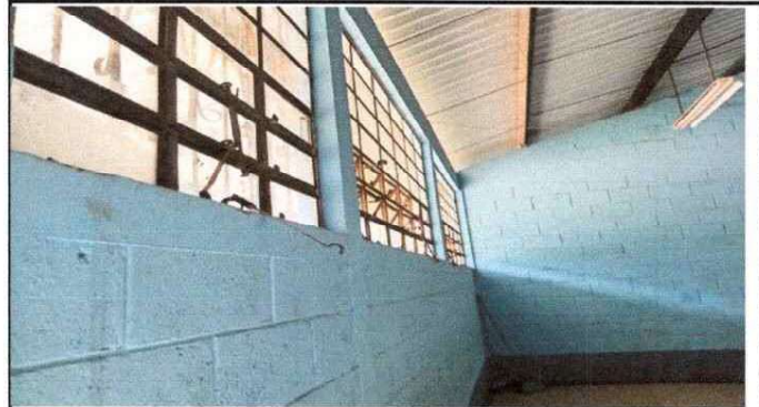
FOTO 1.2: SUSTITUCION DE VENTANAS A PCV
