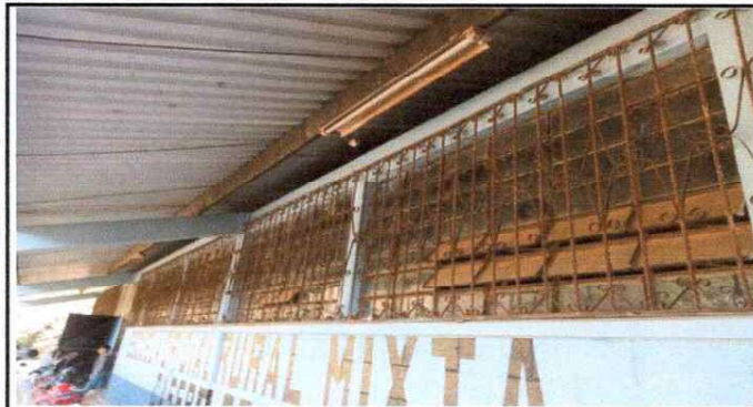
FOTO 1: SUSTITUCION DE BALCONES
