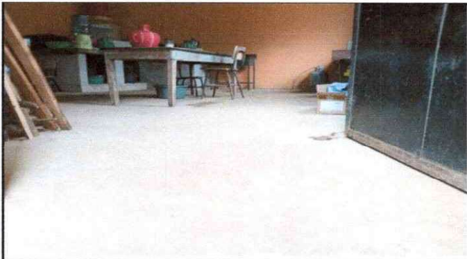
FOTO 1: SUSTITUCION DE PISO A CERAMICO
