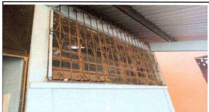
FOTO 1.2: SUSTITUCION DE BALCONES
