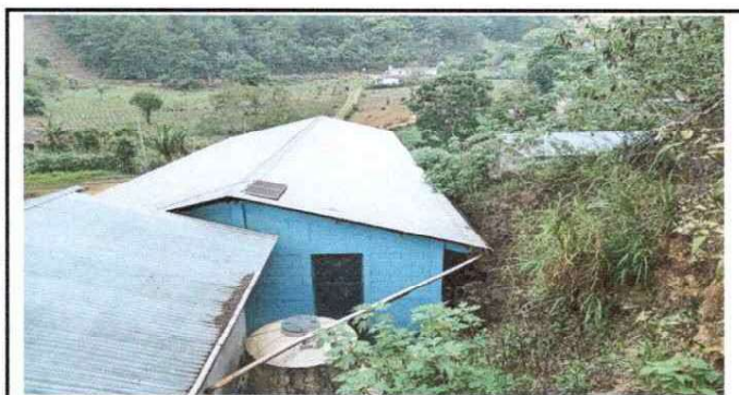
FOTO 1: SUSTITUCION DEL SISTEMA ELECTRICO
