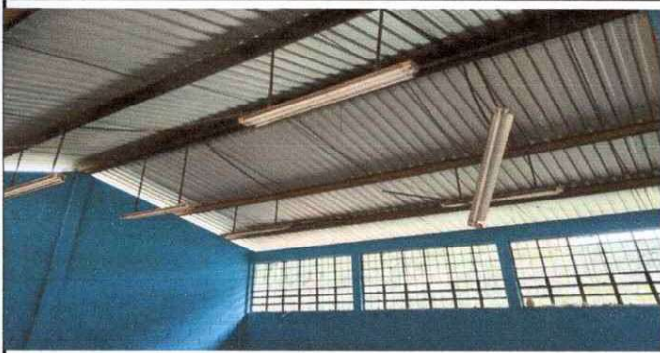
FOTO 1: SUSTITUCION DEL SISTEMA ELECTRICO
